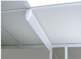
Đèn chiếu sáng được đặt trong các hộp kín nước có nắp nhựa
