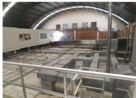
Khu vực phía trên trần treo gồm các tấm panel dạng sandwich
